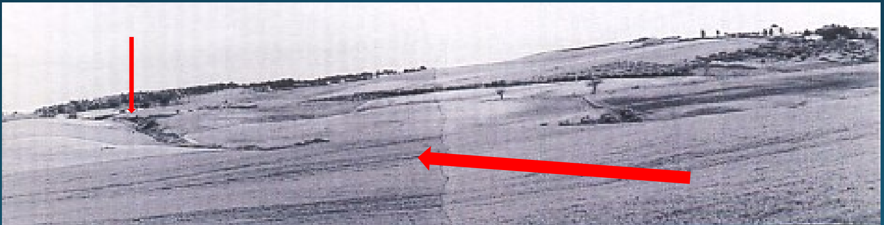
Frana del Versante di Petacciato coinvolgente Aut., FF.SS. E S. St.
